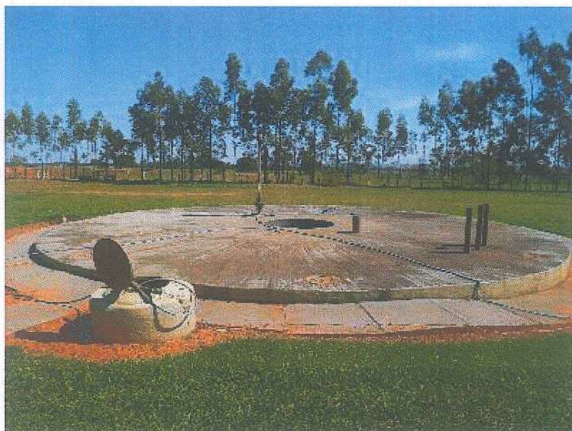
Figura 22 – Estação de Tratamento de Esgoto - RALF
